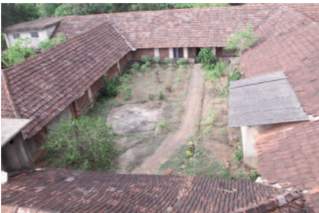
Das alte Generalat ist in seinem derzeitigen Zustand stark renovierungsbedürftig.
